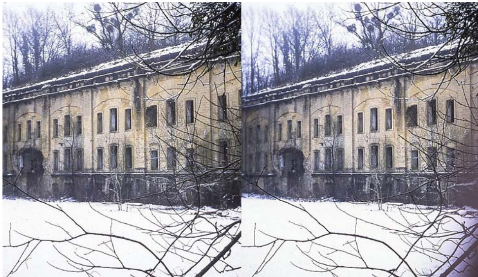
Casernement à l'intérieur de l'enceinte fortifiée - Photo : José Starck 2015
