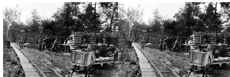
Point de chargement de matériaux divers pour la construction d'abris (bois du Biez - Loriges). Noter les voies de 60 cm et la pousse des wagonnets à la main. Si la plupart des ouvrages sont construits à des points de terrains précis correspondant aux besoins militaires, une petite quantité d'abris sera montée directement à l'intérieur de fermes ou d'habitations (coulage de béton contre les murs intérieurs), essentiellement pour que l'attention de l'ennemi ne soit pas attirée par cette activité. Carte postale allemande - Conversion 2D-3D Leiapix + José Starck.
