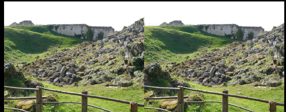
En bas : l'état actuel du donjon démolì. On remarque sur la gauche l'élévation de terrain qui correspond à l'emplacement de la chemise qui entourait la moitié sud de la tour. Photo : José Starck, 2022.
